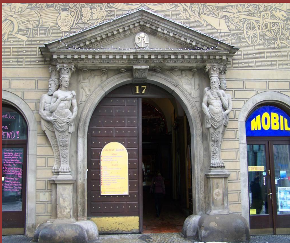
Hlavní vstupní portál
